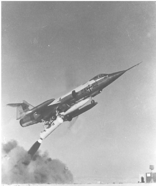
*1. Mai 1966:* Unter der Bezeichnung ZELL (Zero Length Launch) wurde auf dem Lechfeld beim Jagdbombergeschwader 32 der schräge Nullstart einer F-104G STARFIGHTER mit einer unter dem Rumpf montierten Feststoffrakete aus einer speziellen Startrampe erprobt.
